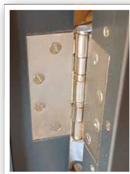
5 zware scharnieren met roulementen
